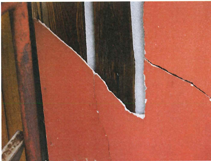
Obr. 7 – fasáda lehká, detail ulomené desky, jih
